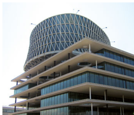
POLO DIREZIONALE DE CECCO Pescara. (ITALY) Arch. Massimiliano FUKSAS
