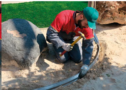
5. Ancoraggio al terreno con picchetti o altri metodi. 5. Anchoring to the ground with pickets or other methods.
