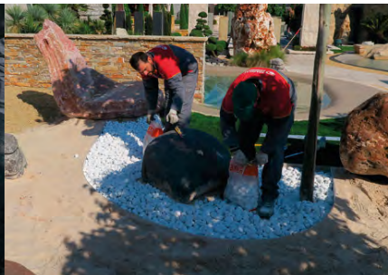
8. Stesura di ciottoli o altro materiale. 8. Laying of pebbles or other material.
