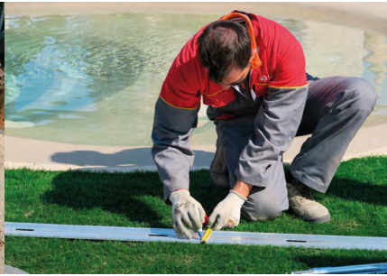
2. Misurazione lunghezza e segnatura per tagli a misura. 2. Measurement of the length for custom cuts.
