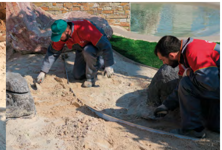
6. Compattazione del terreno intorno alla bordatura. 6. Compaction of the soil around the board.
