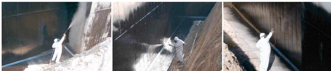
DERMARUBBER S/P : APPLICAZIONE A SPRUZZO SU MURO DI FONDAZIONE
