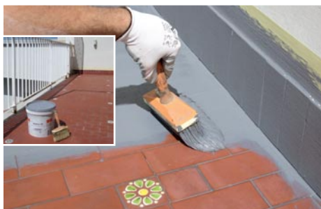
1. APPLICAZIONE DI PRIMER MULTIFIXO 100 SU BALCONE PAVIMENTATO
