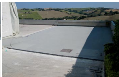
2. POSA DELL'AUTOLIVELLANTE IMPERMEABILE E CARRABILE POLYROOF
