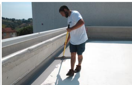
2. POSA DELL'AUTOLIVELLANTE IMPERMEABILE E CARRABILE POLYROOF
