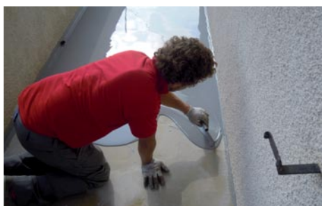
1. APPLICAZIONE DI AUTOLIVELLANTE POLYROOF
