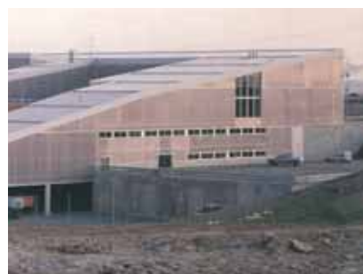
La lastra Lexan Thermoclick* è stata scelta dallo studio di architettura Abalos & Herreros per il rivestimento verticale di questo edificio, grazie alle proprietà termoisolanti e di trasmissione della luce elevata.
