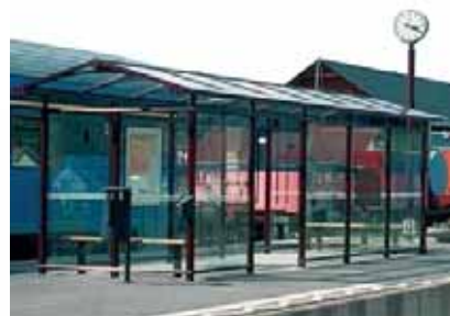
La lastra Lexan Margard* è utilizzata per questa pensilina di attesa dei treni per la resistenza elevata all'abrasione e all'impatto, nonché la durata contro eventuali atti vandalici.
