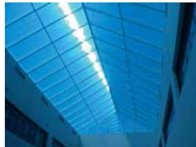
La lastra Lexan Thermoclear Sun XP, con protezione dai raggi UV su entrambi i lati, è utilizzata per il tetto di vetratura di questa scuola ad Al Wasel, UAE Dubai.
