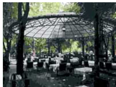
Il ristorante Madera di Belgrado ha scelto la lastra Lexan Thermoclear per la realizzazione della tettoia, grazie all'eccellente trasmissione della luce, alla facilità di installazione e alla protezione dai raggi UV su entrambi i lati.
