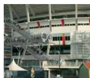
L'Amsterdam Arena ha scelto la lastra Lexan Solar Control IR* come materiale per la vetratura dei tunnel delle scale mobili dei quattro lati dello stadio.
