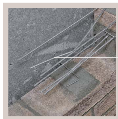
CLIP ARCHITRAVE inserita nelle fughe verticali tra un mattone e l'altro, agganciata all'armatura orizzontale WALL FORCE
