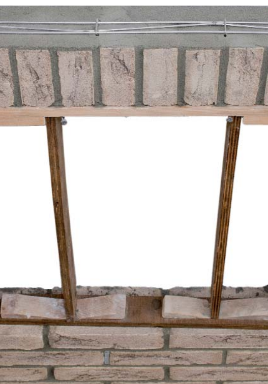
Armatura orizzontale WALL FORCE su architrave.
