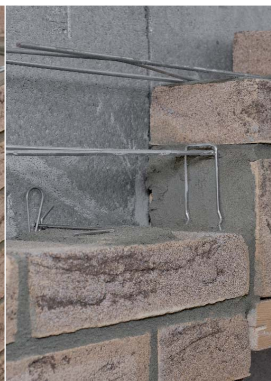
Gancio CLIP ARCHITRAVE applicato nelle fughe verticali.
